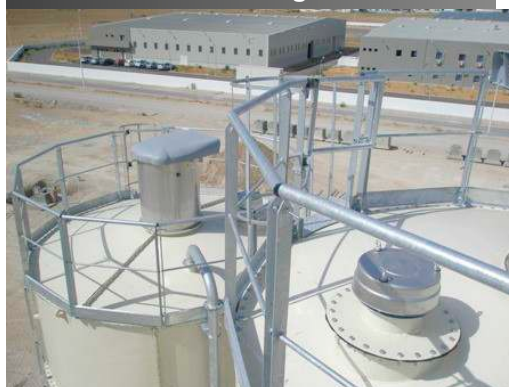
Détaille filtre et parapet
